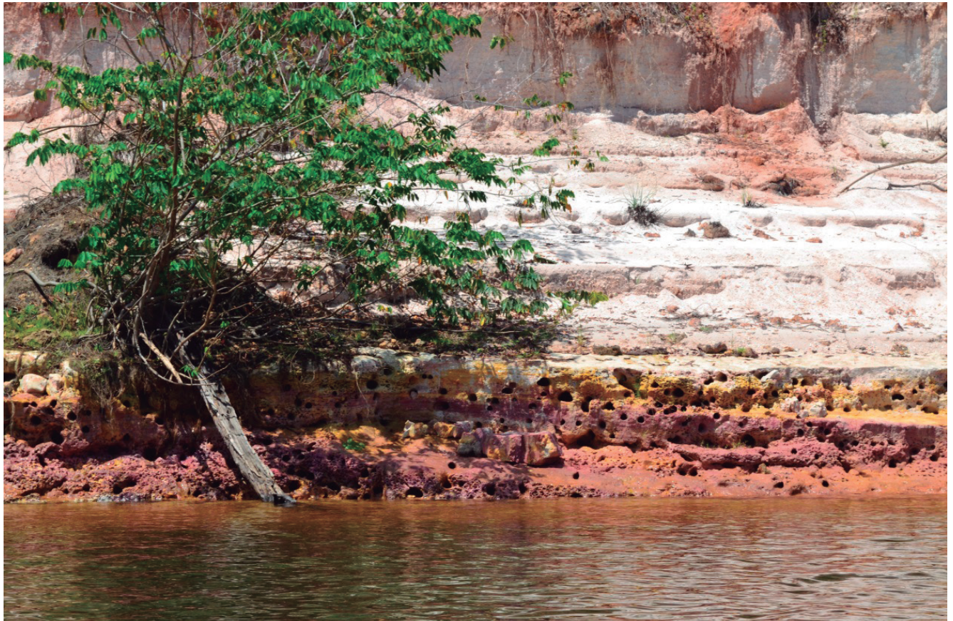
Figura 2 Erosão e assoreamento do rio. Autoria: Matheus Benassuly
