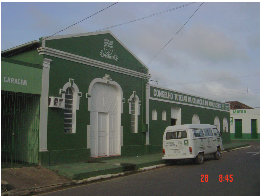
Figura 1 - Fachada do antigo Mercado e Feira Municipal de Altamira, janeiro de 2006. Foto de Gutemberg Guerra
