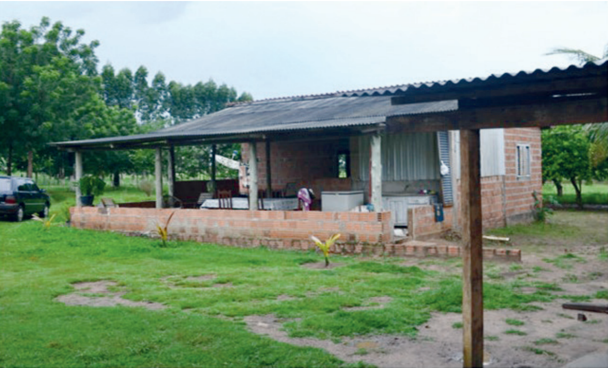
Figura 3 – Moradia na Comunidade Vale do Sol II
