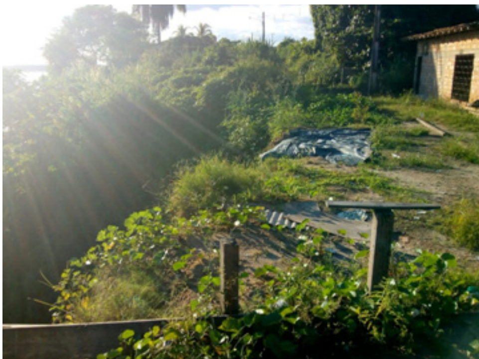
Figura 12: Erosão em trecho da rua 15 de Novembro
