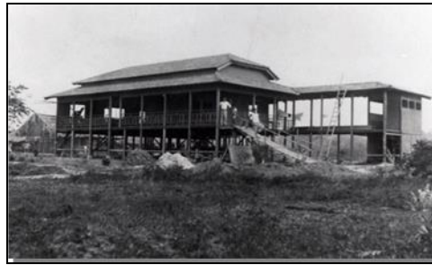
Fig. 2: Barracão onde ficava a fibra da juta, na Vila Amazônia
